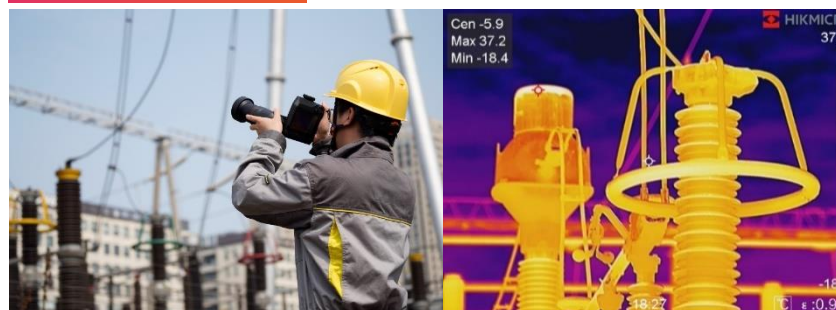
Inspección de energía Electricistas
